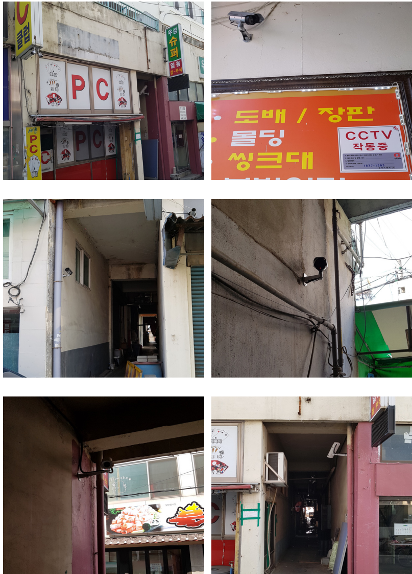
[그림 4-4] CCTV 설치 시공
