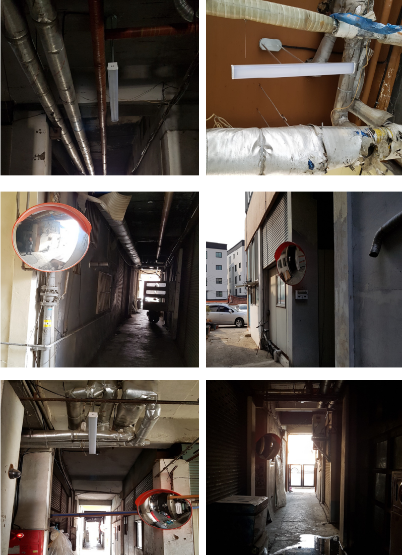
[그림 4-3] 내부 조명 및 반사경 설치 시공
