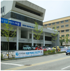
도로에 면한 전경(종촌동)
