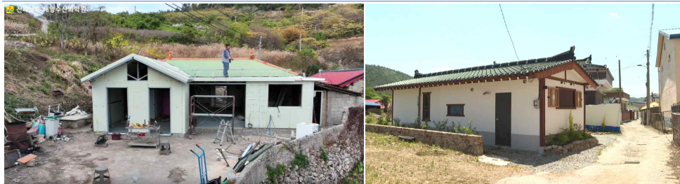
전남 귀어·귀촌인 주택 리모델링 공사 모습
