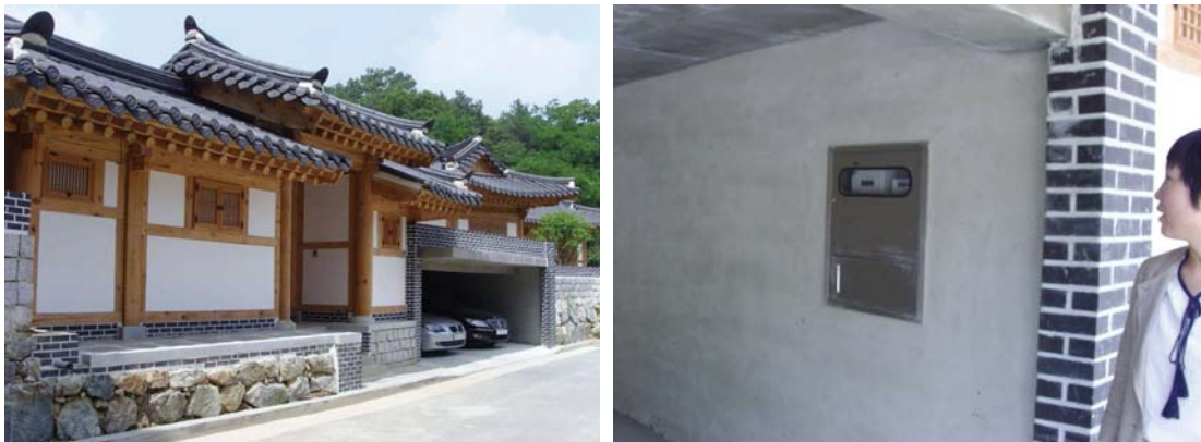
[그림 3-24] 오창미래지 한옥마을 한식대문과 주차장에 매립된 계량기함(2016.6. 촬영)
