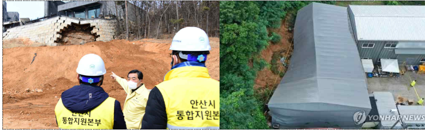
[그림 2-8] 안산 옹벽 붕괴 사고(좌), 폭우로 인한 옹벽 붕괴 사고(우)
