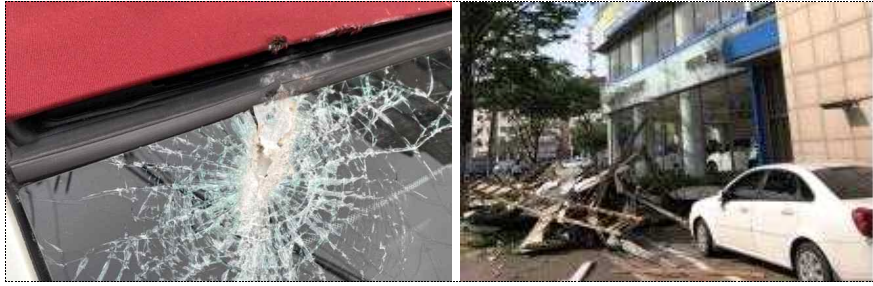
[그림 2-4] 광고판 낙하로 인한 차량 파손(좌), 광고판 철거 중 낙하 사고(우)
