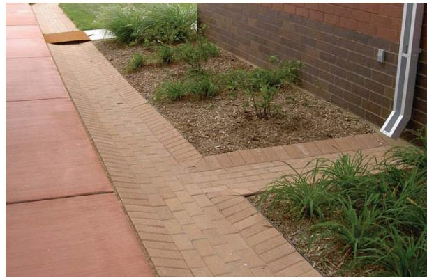
[그림 4-93] 보도에 Channel와 Runnel가 적용된 사례
