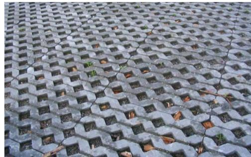
[그림 4-90] 투수성 포장 예시
