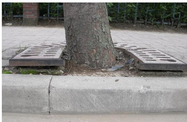
[그림 4-85] 보호시설 불량으로 인한 보행권 침해
