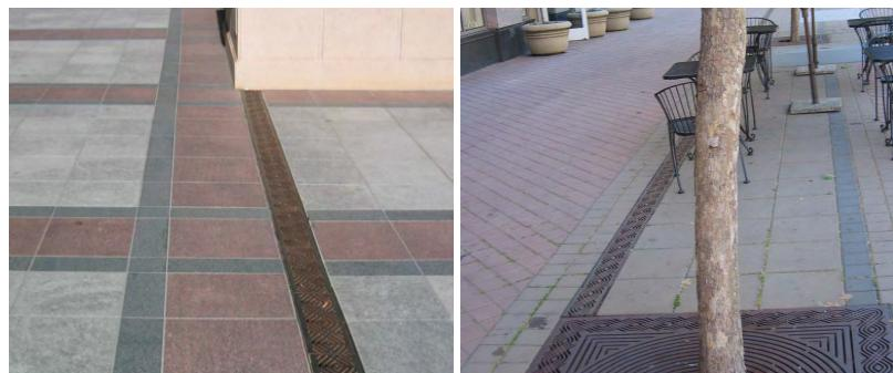
[그림 4-94] 투수성 트렌치 예시
