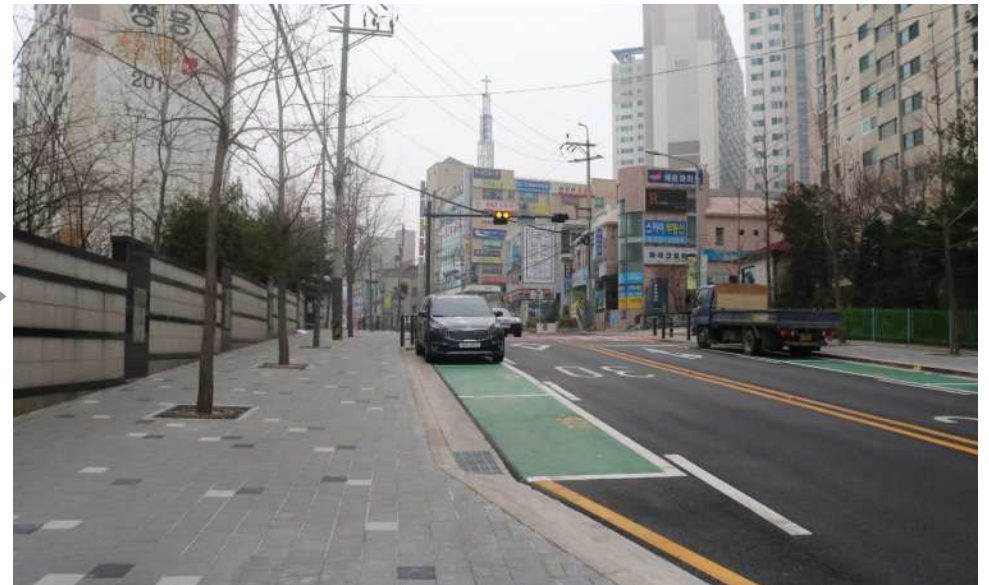
C(사후) 보도 확장 및 포켓주차면 설치
