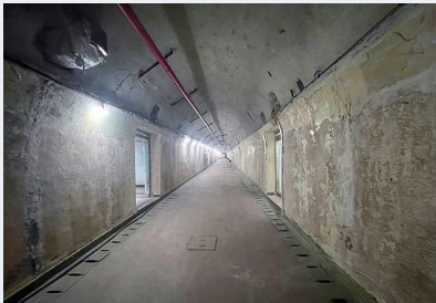
당산 터널 내부 출처: 충청북도. (2023). 충북도, 당산 빈 터널 (舊 총무시설)을 도민의 품으로. 11월 19일 보도자료.
