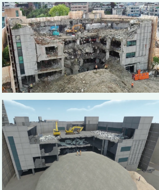
서울시 철거 공사장 붕괴사고 대응훈련 시뮬레이션 영상 출처: 서울시. (2021). 서울시, 철거 공사장 붕괴사고 가정한 재난대응훈련 실시. 10월 29일 보도자료.
