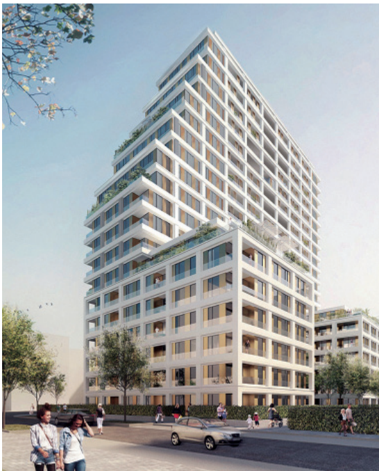
상 독일 최대 높이 주거타워 Tower 2
